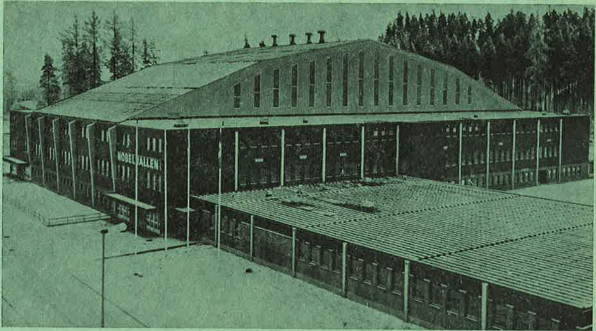
Nobelhallen i Karlskoga – nyaste ishallen i Värmland, togs i bruk hösten 1972. Hallen rymmer 6.500 åskådare, varav 1.300 är sittplatser. Ishockeybanan är upp- spolad på en betongplatta med 12 km kylrör. Hallen ägs av Karlskoga kommun.
