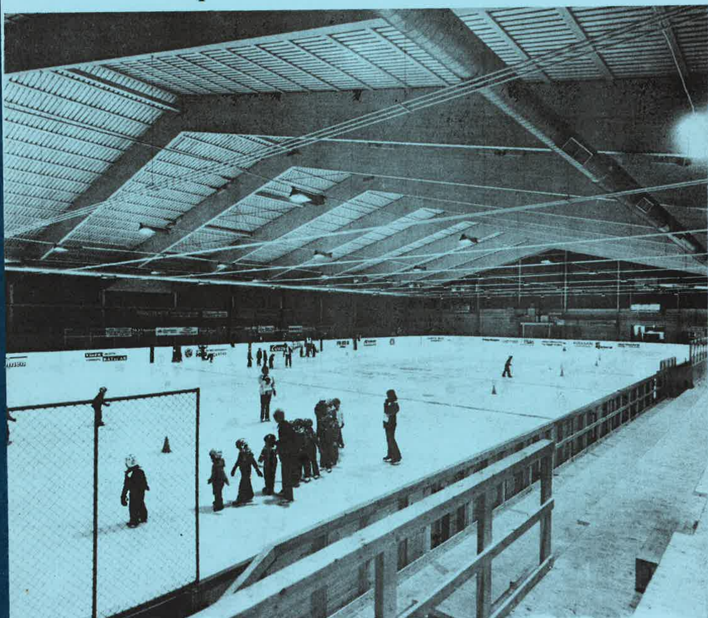
Interiör från Hammarö Ishall, som togs i bruk i december 1979. Foto: Stig Gustavsson, Bromma
