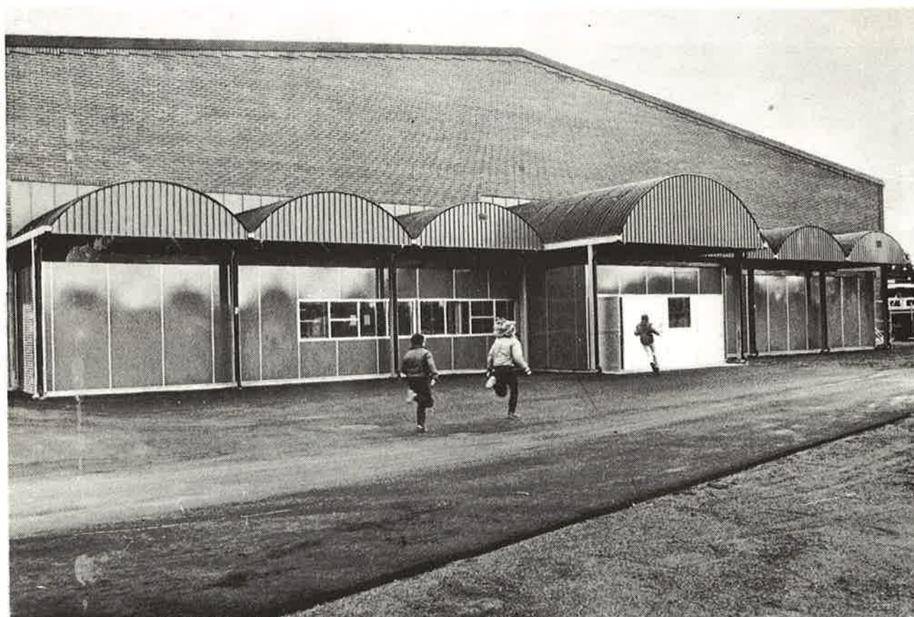
Omslagsbilden: BJÖRKHALLEN, KRISTINEHAMN som invigdes 14 november 1981. Byggherre: ABV (Armerad Betong Vägförbättringar AB)
